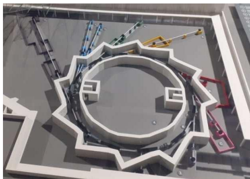
Rys. 1. Schemat synchrotronu SOLARIS z zaznaczonymi liniami badawczymi.
